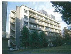
旧工学部3号館
