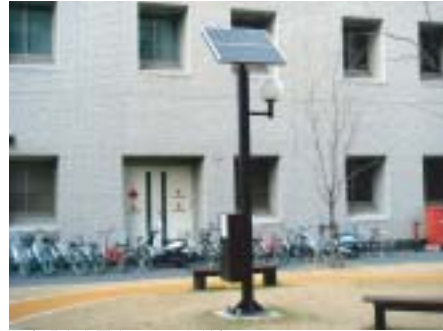
■太陽光発電を利用した外灯 パンプエネルギー(太陽光)を積極的に利用し、省エネルギーを図った例。発生医学研究センター(中地区)前の広場に設置。
