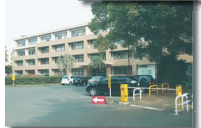
改修後：薬学部本館耐震補強
