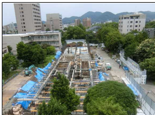
①躯体工事（基礎・1階）
