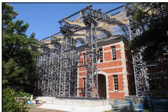
五高記念館 素屋根鉄骨工事了
