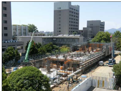
②躯体工事（1階・2階）
