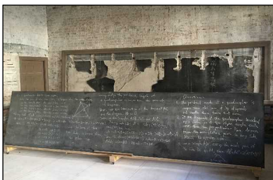
五高記念館 内部漆喰壁・黒板解体完了
