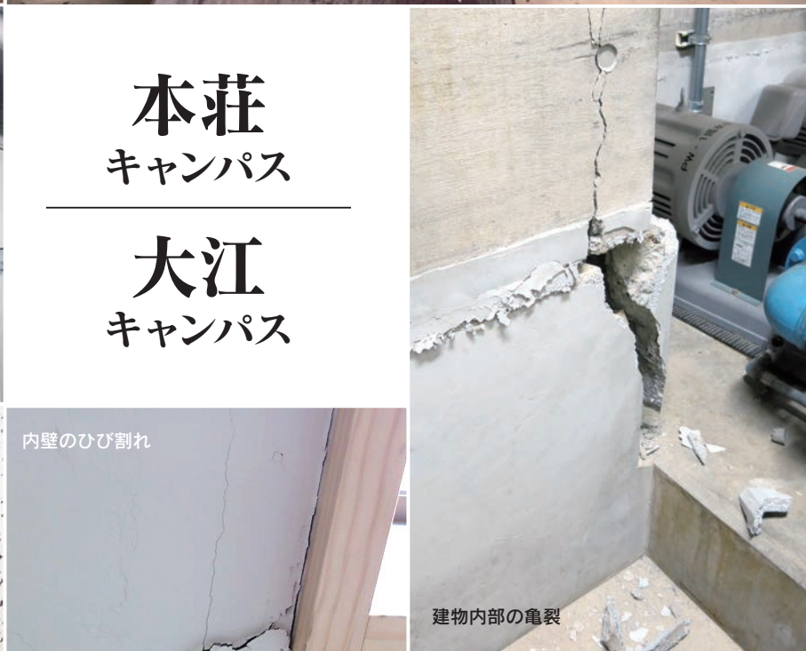
建物接続部の変形
