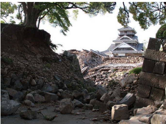
大きく壊れた頼当御門の枡形の石垣と背後に雄々しく立つ宇土櫓
