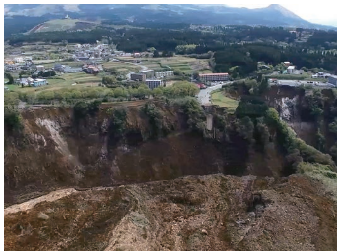
阿蘇大橋周辺の土砂崩れ（提供：国土地理院）
